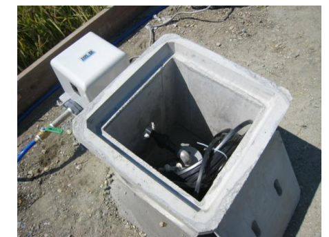
深井戸地上部完成写真
