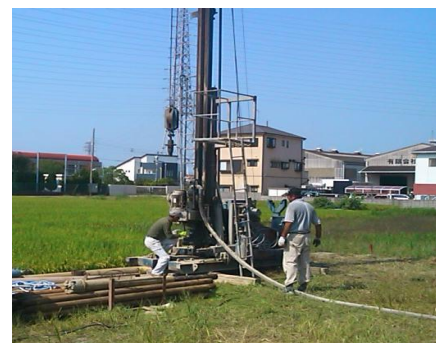
深井戸掘削工事
